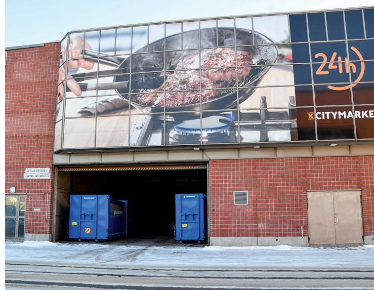
Normaalia kapeampi Combi-puristin suunniteltiin takatilaan, jossa jakeluauto mahtuu hyvin hoitamaan tavaralogistiikkaa kahden puristimen välistä.
