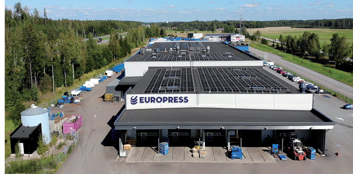
Europress on panostanut omaan aurinkovoimalaan, joka tuottaa vuosittain 330 MWh sähköä. (Kuva: Solarico)
